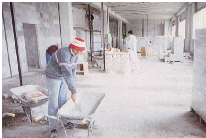
Приготовление раствора BETONKOL K9
