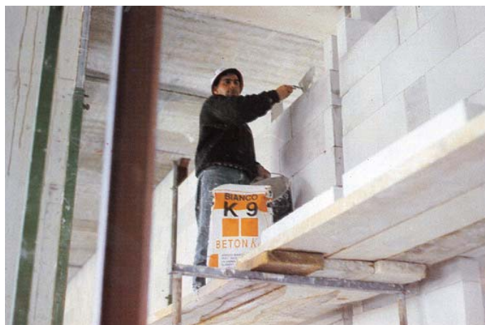
Кладка перегородок из пеноблоков
